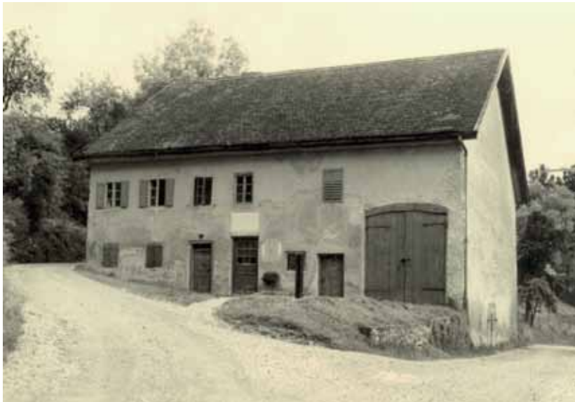
Das ehemalige Mesnerhaus an der Leitenhöhe, das auch als Schulhaus und Schreibstube diente, abgerissen 1961, an gleicher Stelle neu gebaut
